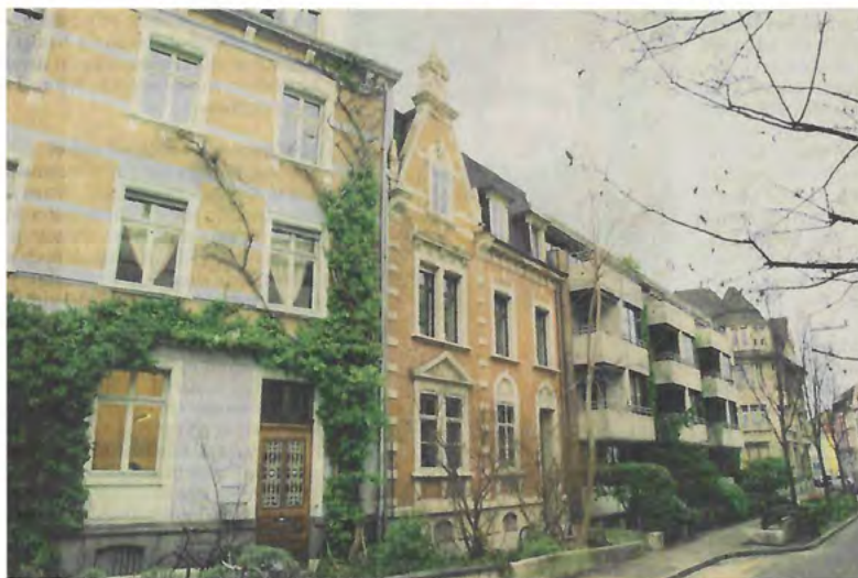
Das Haus Holbeinstrasse 76 (Mitte) vor dem Abbruch. Der Neubau dient dem Alters- und Pflegeheim Hasenbrunnen (rechts), dessen Trägerschaft auch das Haus Nummer 76 gehört.
