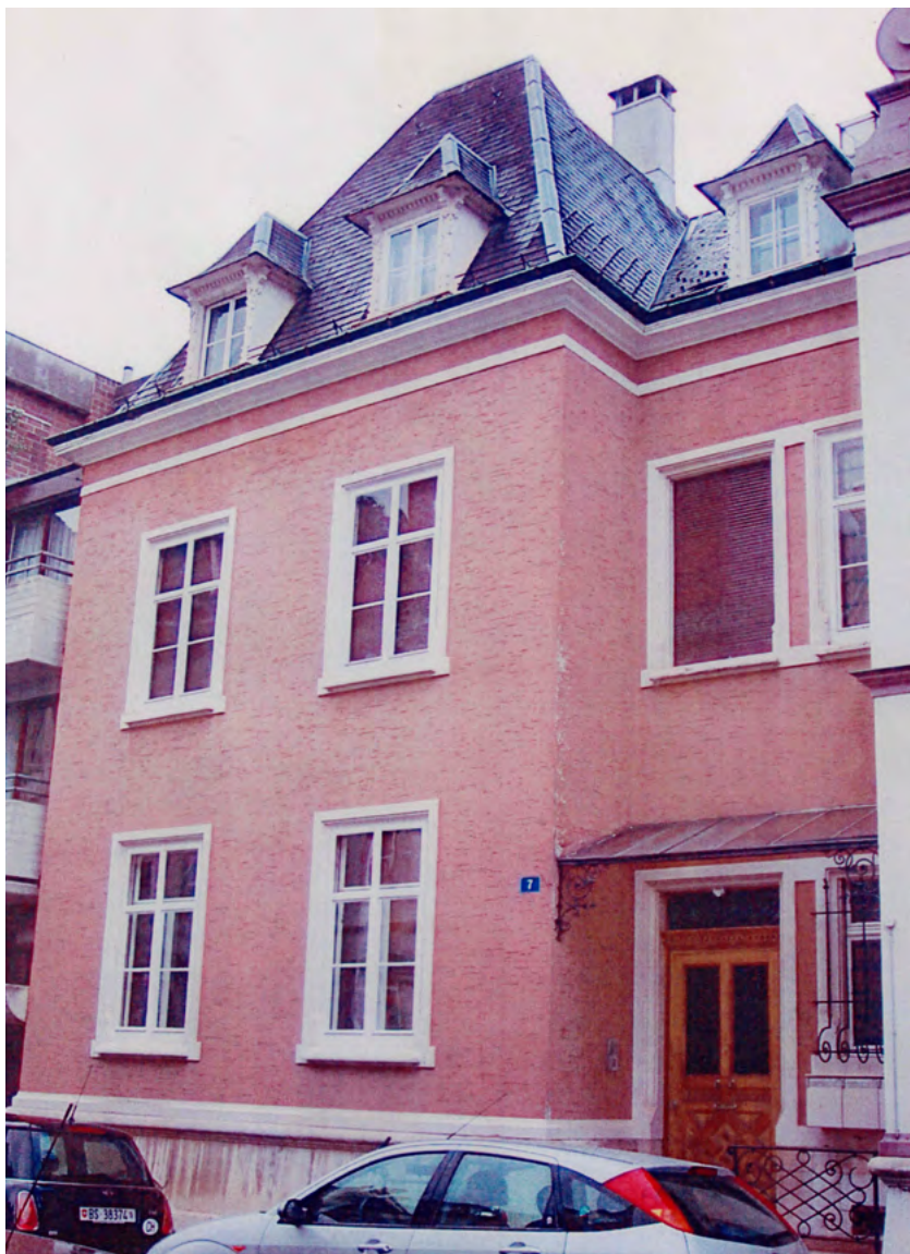
Die Liegenschaft an der Feierabendstrasse 7 diente als Nebeneingang zur Wohnung des Heimleiterehepaars und Eingang für die extern wohnenden Angestellten.
